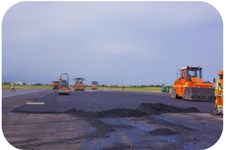
Mise en conformité et de resurfacement de la piste d'atterrissage.
