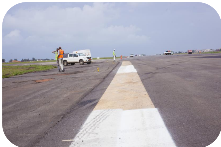
Mise en conformité et de resurfaçage de la piste d'atterrissage.
